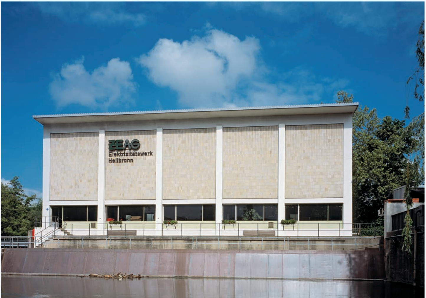
Wasserkraftwerk der ZEAG 1955, Aufnahme von 2004, Heilbronn
